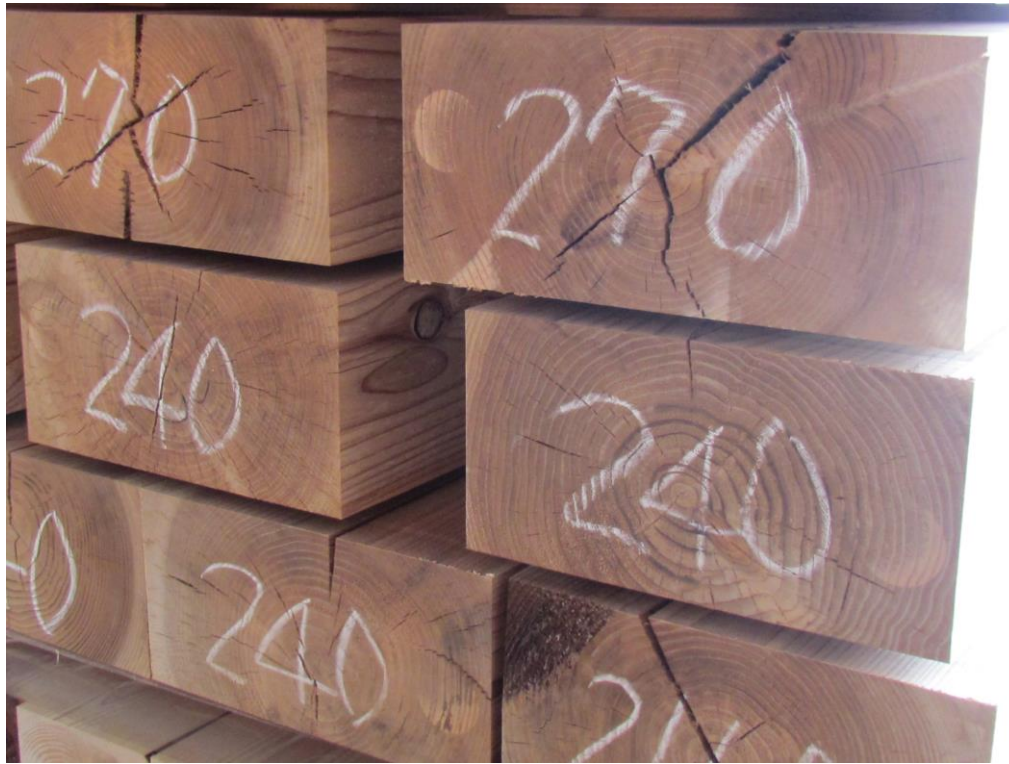
スギ横架材内部割れ
